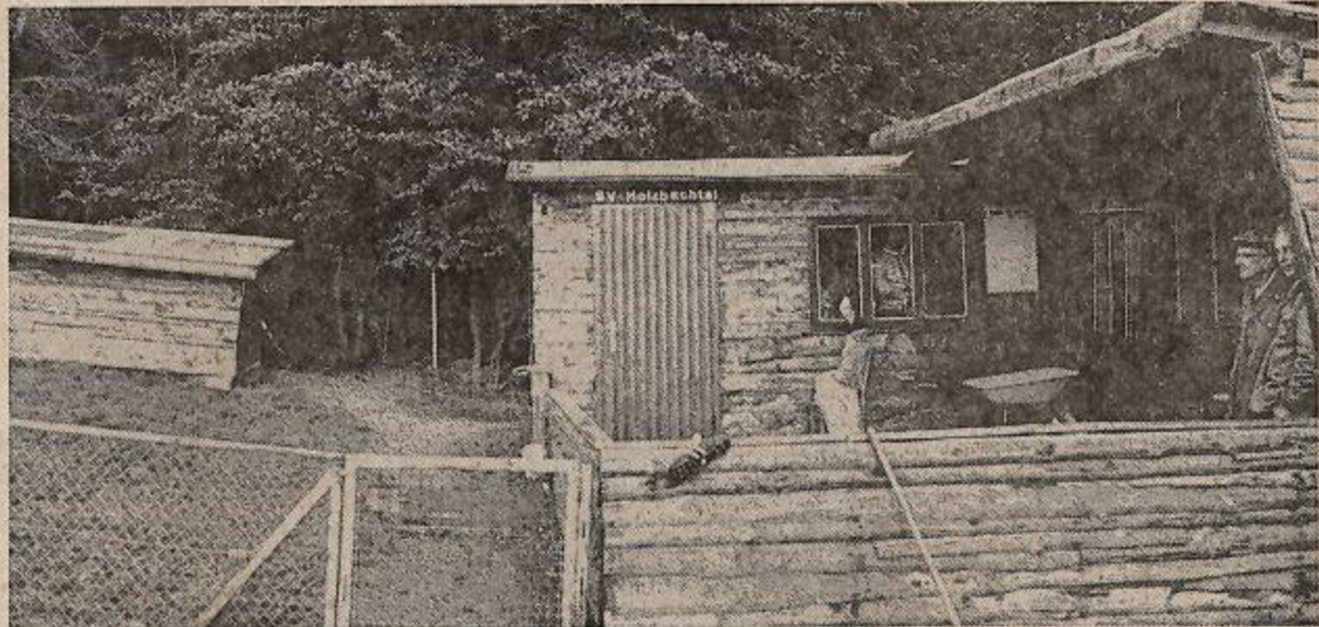
Das rustikale Vereinshäuschen mit einem gemütlichen Aufenthaltsraum haben die Mitglieder des SV Holzbachtals selbst gebaut. Außerdem wurde das gesamte Übungsgelände von ihnen eingezäunt und eine Anzahl Hundeböden errichtet, in denen sich die Hunde während der Trainingspausen aufhalten (links).
